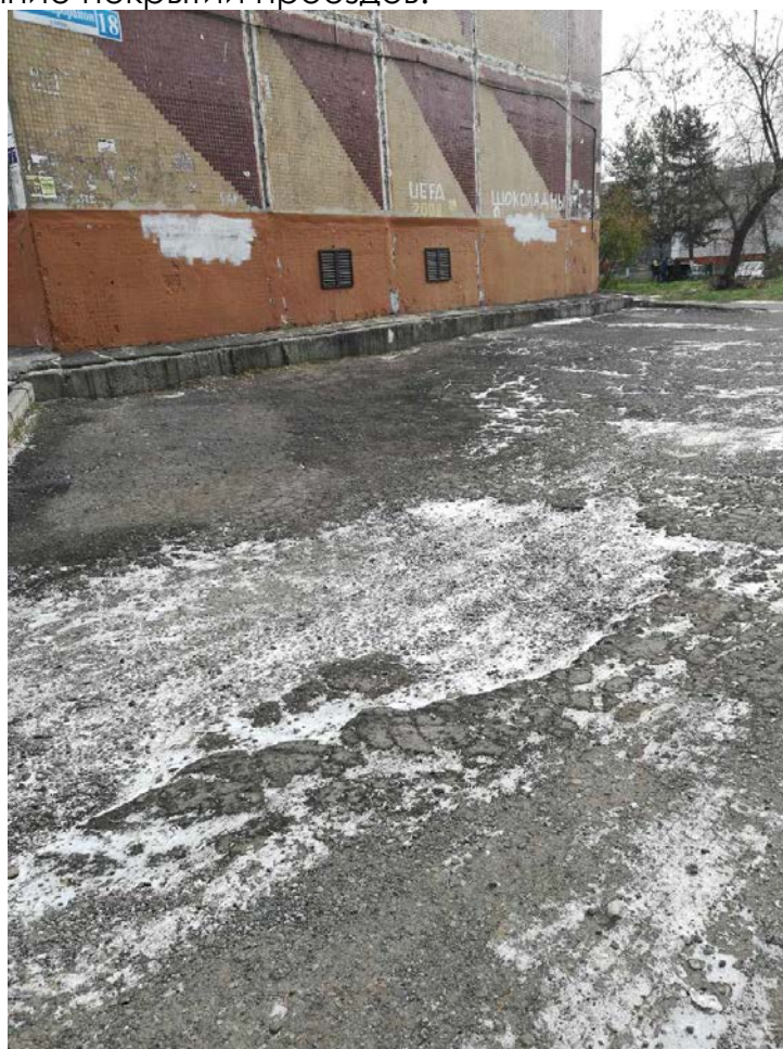
Рис. № 2. Состояние покрытий проездов.
